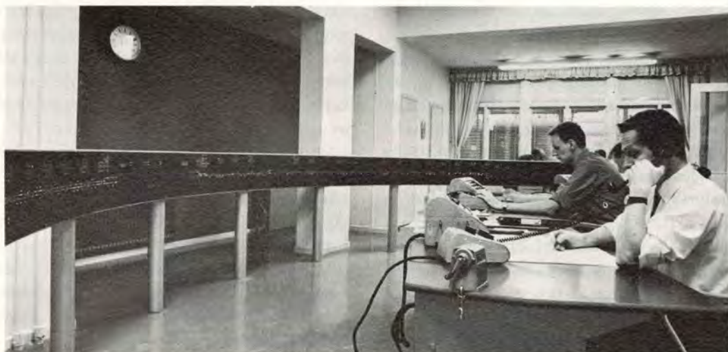
Tågens rörelser styrs och övervakas genom fjärrmanövrering av växlar och signaler inom stora områden från centralt placerade ställverk. Bilden visar ett CTC (Centralized Traffic Control) ställverk i Ånge.
